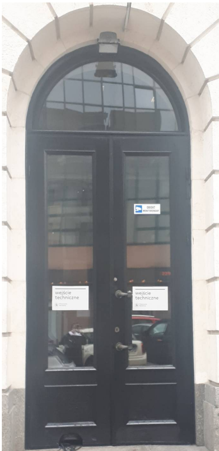
Widok drzwi w elewacji zachodniej (od pl. Młynarskiego) – - przeznaczonych do wymiany na drzwi DZ-1
