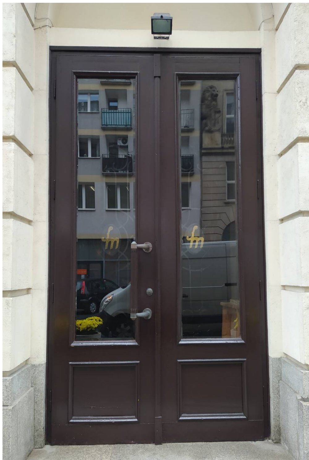
Widok drzwi w elewacji północnej (od ul. Moniuszki) – - przeznaczonych do wymiany na drzwi DZ-2
